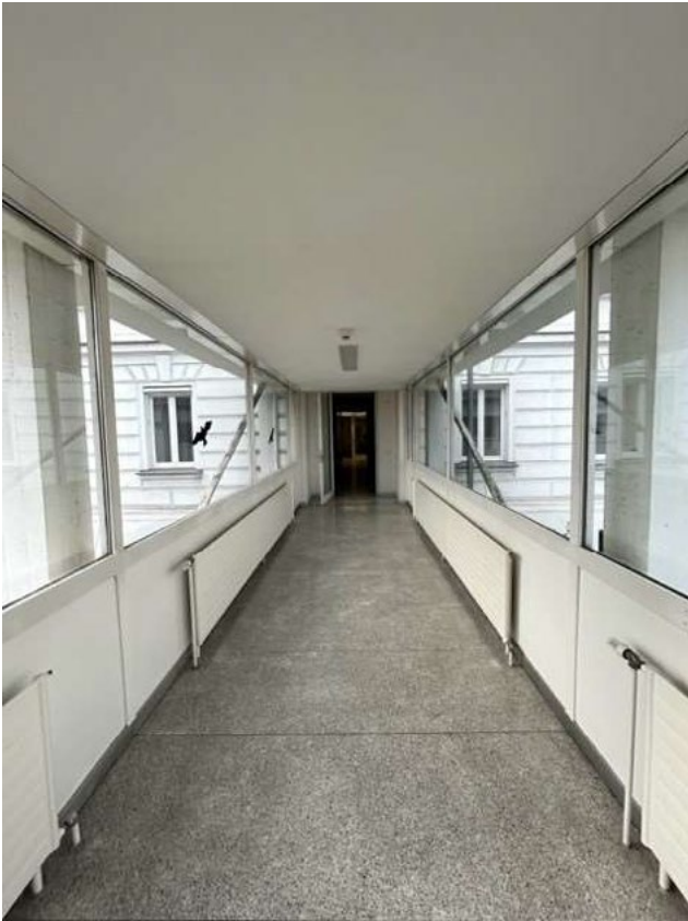
1 Fußwegbrücke von Gebäude B zu Gebäude C
