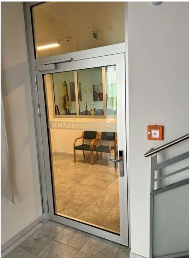
6 Zugang aus dem Stiegenhaus zu Gebäude D (→ mit Chip öffnen)
