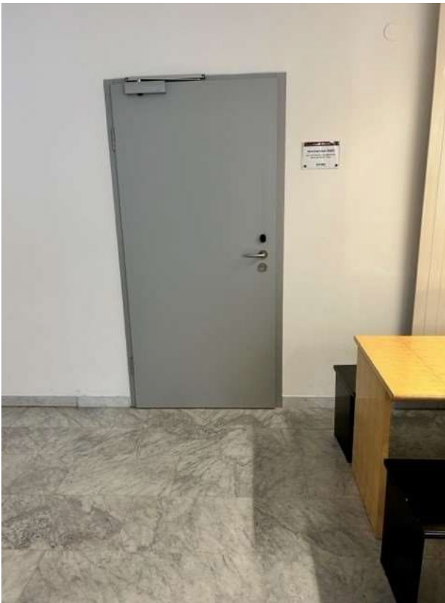
3 Tür zum Stiegenhaus in Gebäude D (→ mit Chip öffnen)
